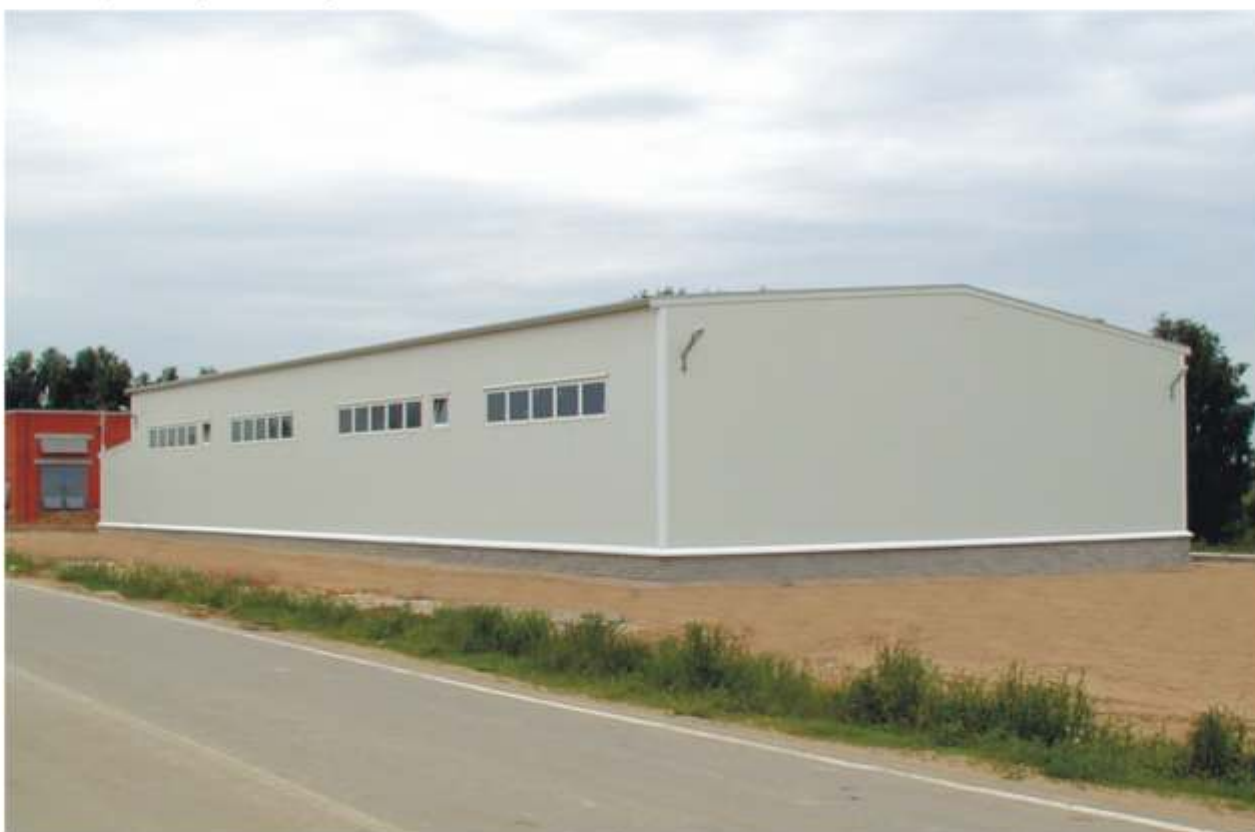
Станция биологической очистки, Московская обл.
